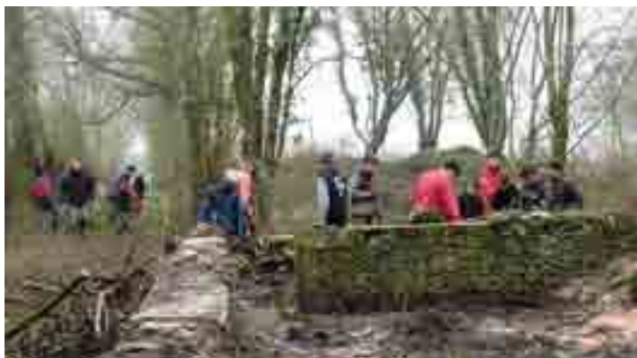
Chantier Restauration du lavoir de Fénerly avec la MFR Saint-Loup-sur-Thouet (Nature et Transition, Région Nouvelle-Aquitaine)
